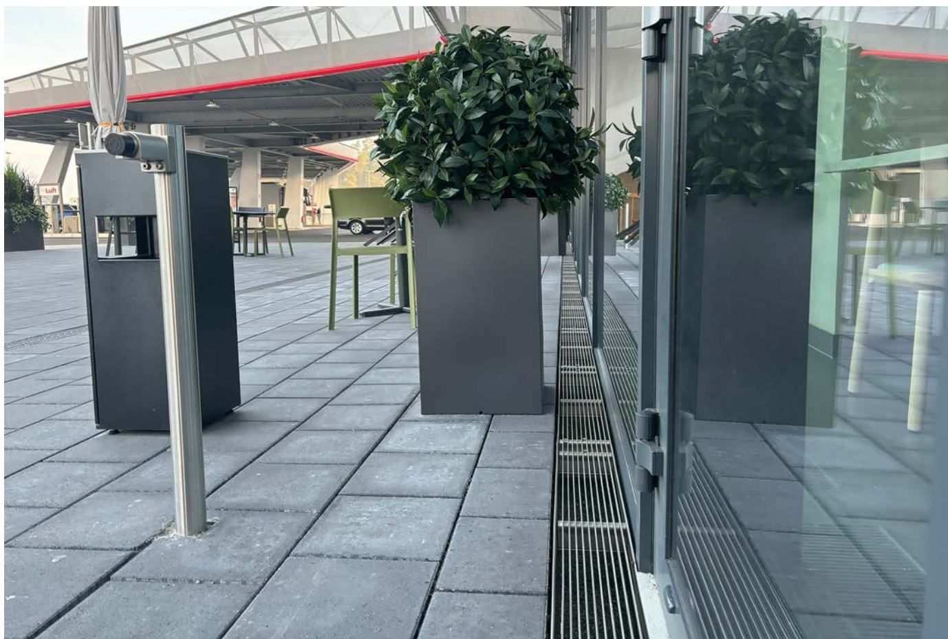
Barrierefreie Fassadenentwässerung vor Glasfassaden
