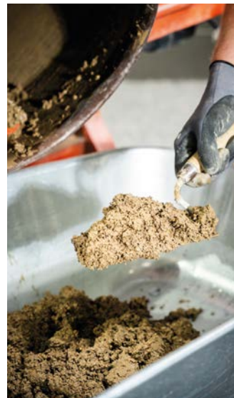
Beim Mischen löst sich der Sack komplett auf
